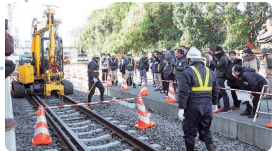
ダンパバックハウによる 道床つき固め
